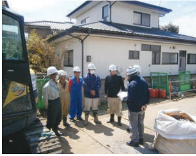
■現場作業員に指導員、組合理事が安全工事の説明
