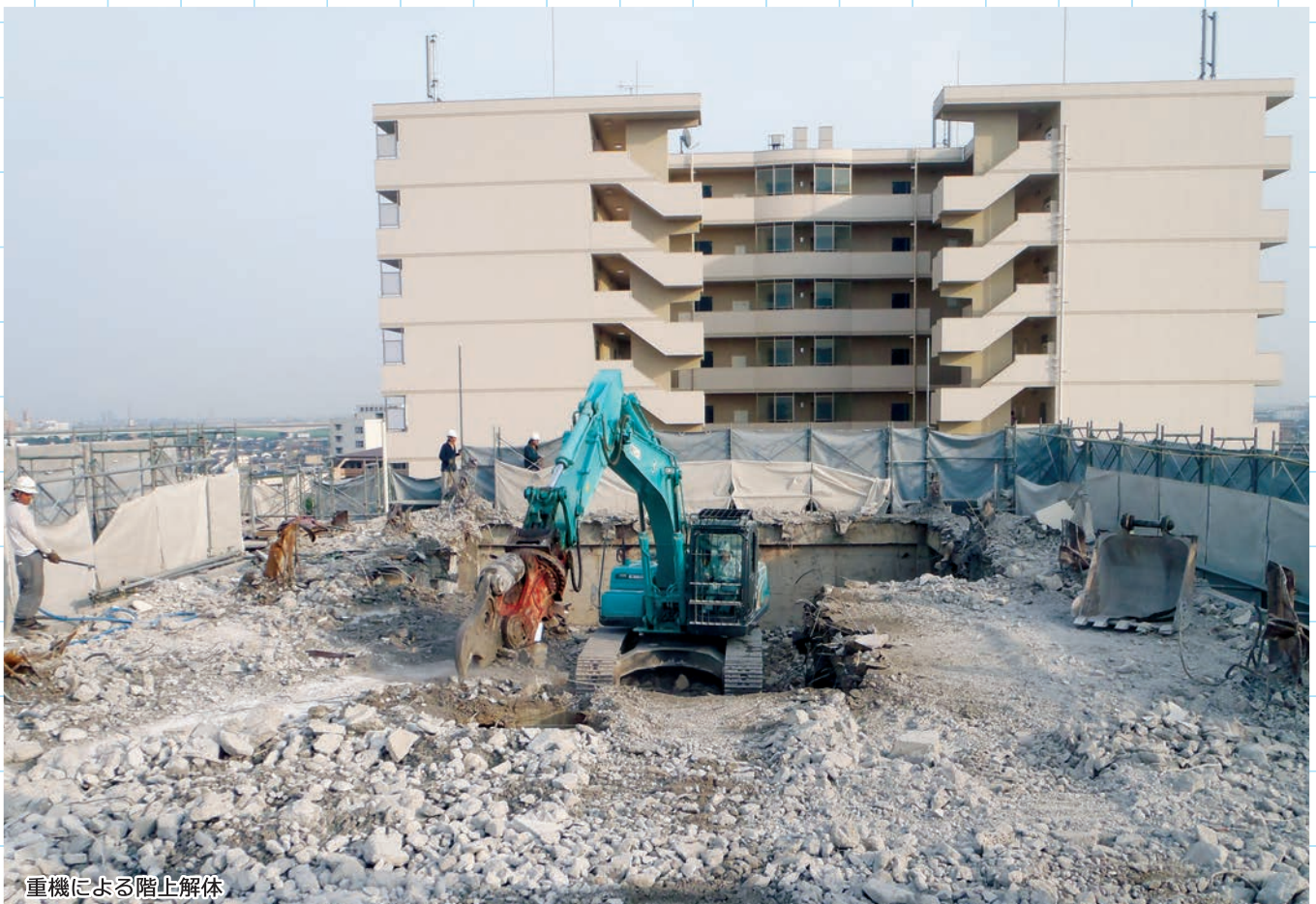
仮設ガラスロープを作り下階へ解体機を移動。
