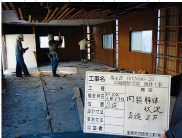
2階部分内装解体
