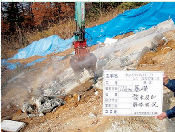
基礎部分解体
