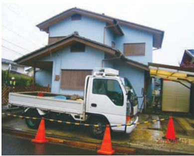
■ 工事車両をゲートとコーンで安全確保
