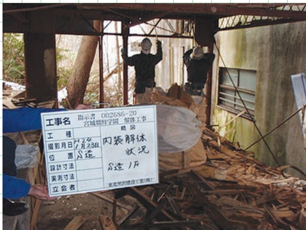
1階部分内装解体
