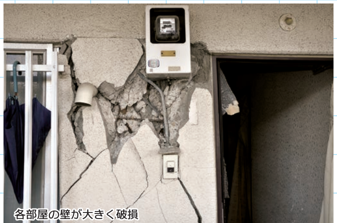
1階から14階の最上階まで亀裂が走る
