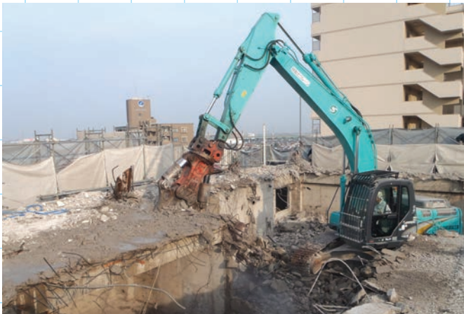
屋上床に穴をあける削孔工事
