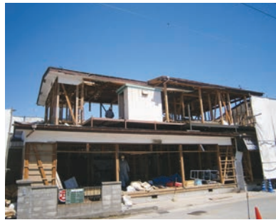
■ 分別解体で施工
