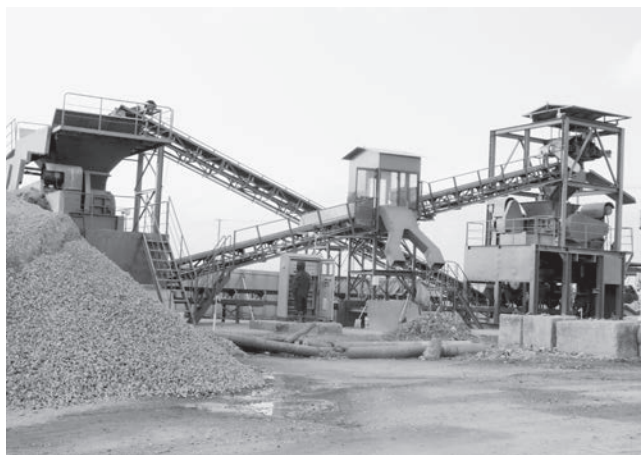
復旧したプラント施設
