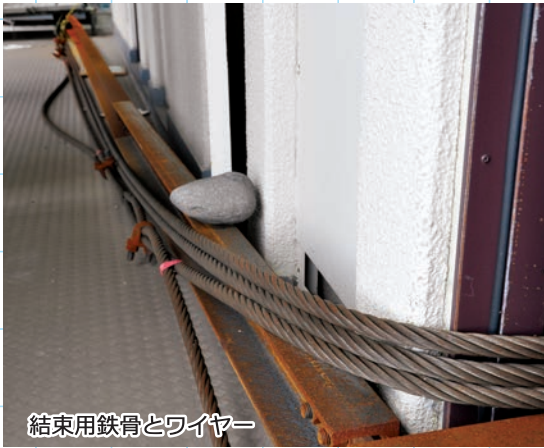
A棟(右・南側)が剥離したため、鉄骨とワイヤーでB棟(左・北側)と結束し応急の倒壊防止を施す(写真中央部が結束部)
