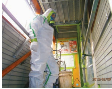
■防塵服を着用しアスベスト除去
