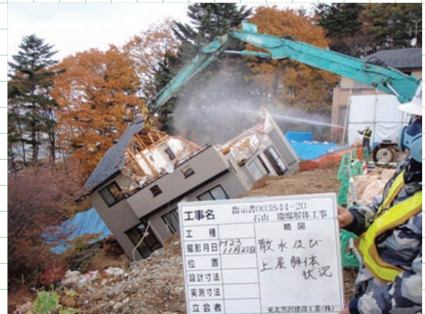
散水及び上屋解体工事
