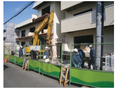
■ 道路にガードフェンスを設置し安全確保
