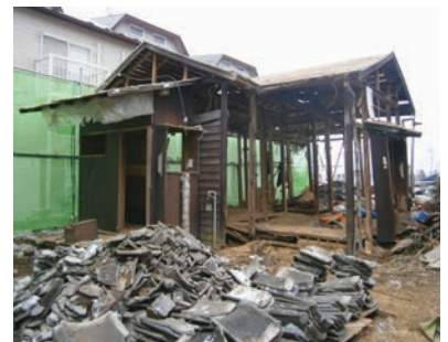
■ 屋根瓦を分別撤去
