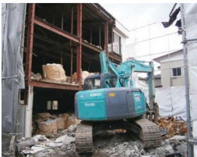
■ 仙台市街地では施工場所の確保が難しく、また騒音、粉塵など近隣への配慮が欠かせない
