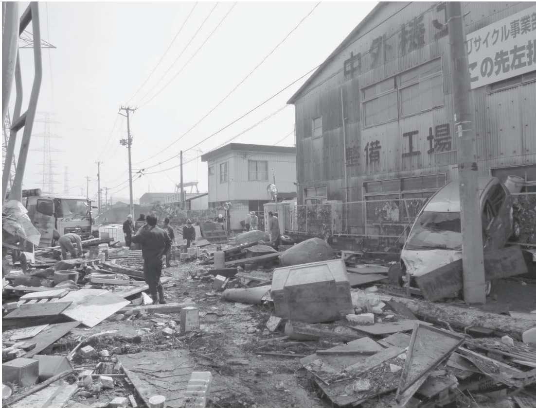
敷地内にガレキが堆積
