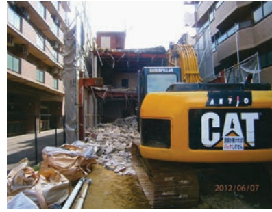
■集合住宅地の狭あい地ではより安全作業が要求される
